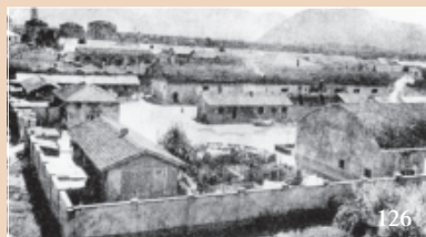
126. Edifici adibiti a blocchi per i deportati ed all'amministrazione del Lager di Bolzano.
